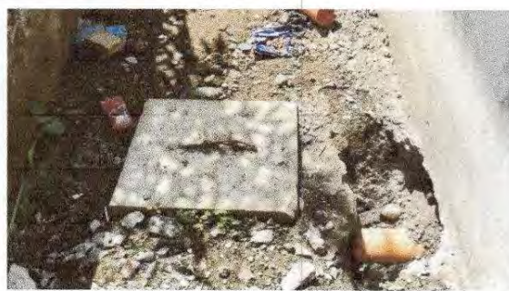
FOTO 14: Sustitución de caja de registro
