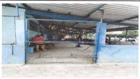
foto 9: Fabricación e instalación de portón de metal de ingreso
