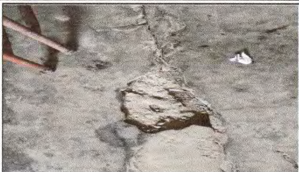
FOTO 1: Sustrución de piso cerámico
