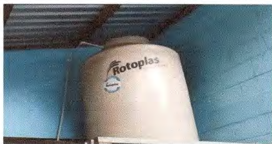
foto 5: Sustrución de depósito de agua 1100 lt
