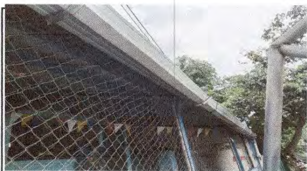
foto 6: Sustrución de canal de metal
