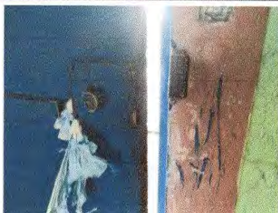
foto 11: sustitución de chapa
