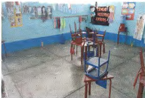
FOTO 13: Pintura en muros exteriores e interiores
