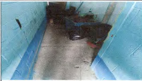
FOTON 2: Sustrución de piso cerámico
