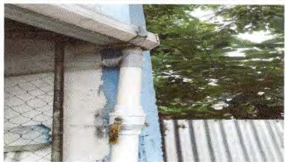
foto 7: Reparación de bajada de agua pluvial, tubo PVC 3"
