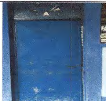
foto 10: Mantenimiento a estructura (lijado, cambio de tubo, cepillado, sujeciones, aplicación de pintura)
